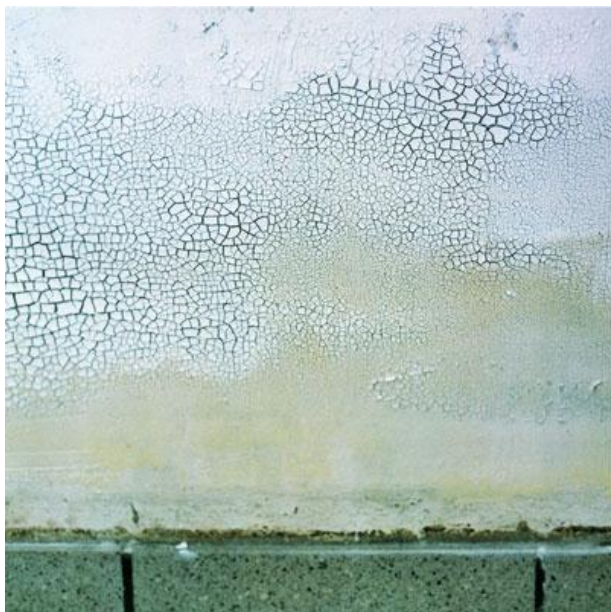
Aangebrachte PCI ENTÖLER bindt de opgeloste vervuiling en droogt als een korst uit
