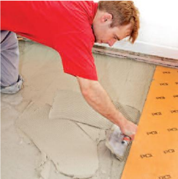
Op de voorbereide ondergrond PCI NANOFLOTT LIGHT of PCI RAPIDFLOTT opkammen.
