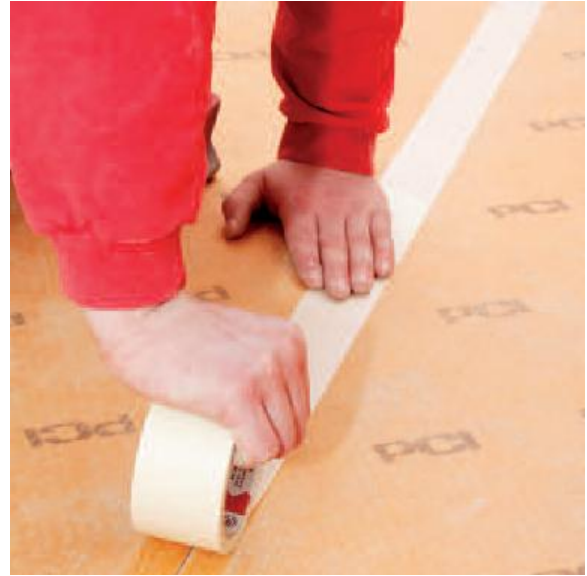
In droge ruimtes de stootkanten met afplakband afplakken, in natte ruimtes met PCI PECITAPE.
