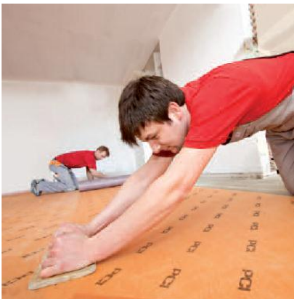
PCI PECILASTIC U neerleggen en aandrukken, bijvoorbeeld met een houten plank of voegbord van hard rubber.
