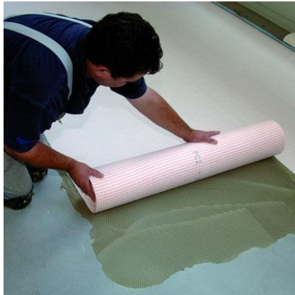
worden de PCI PECILASTIC banen aangebracht
