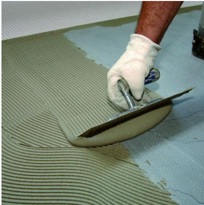
In de vers aangebrachte lijmlaag
